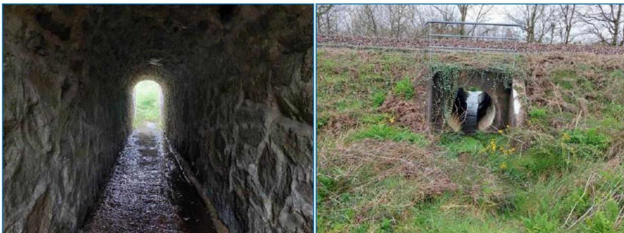
Figure 85 - Ouvrages hydrauliques : sous la ligne ferroviaire abandonnée (à gauche) et sous la ligne ferroviaire en activité
